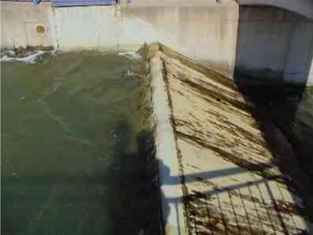
Verbindungswehr zwischen den Kanälen
