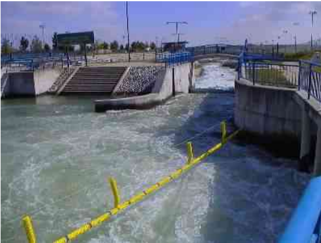
Einfahrt rechter Kanal, von rechts Wasserzulauf
