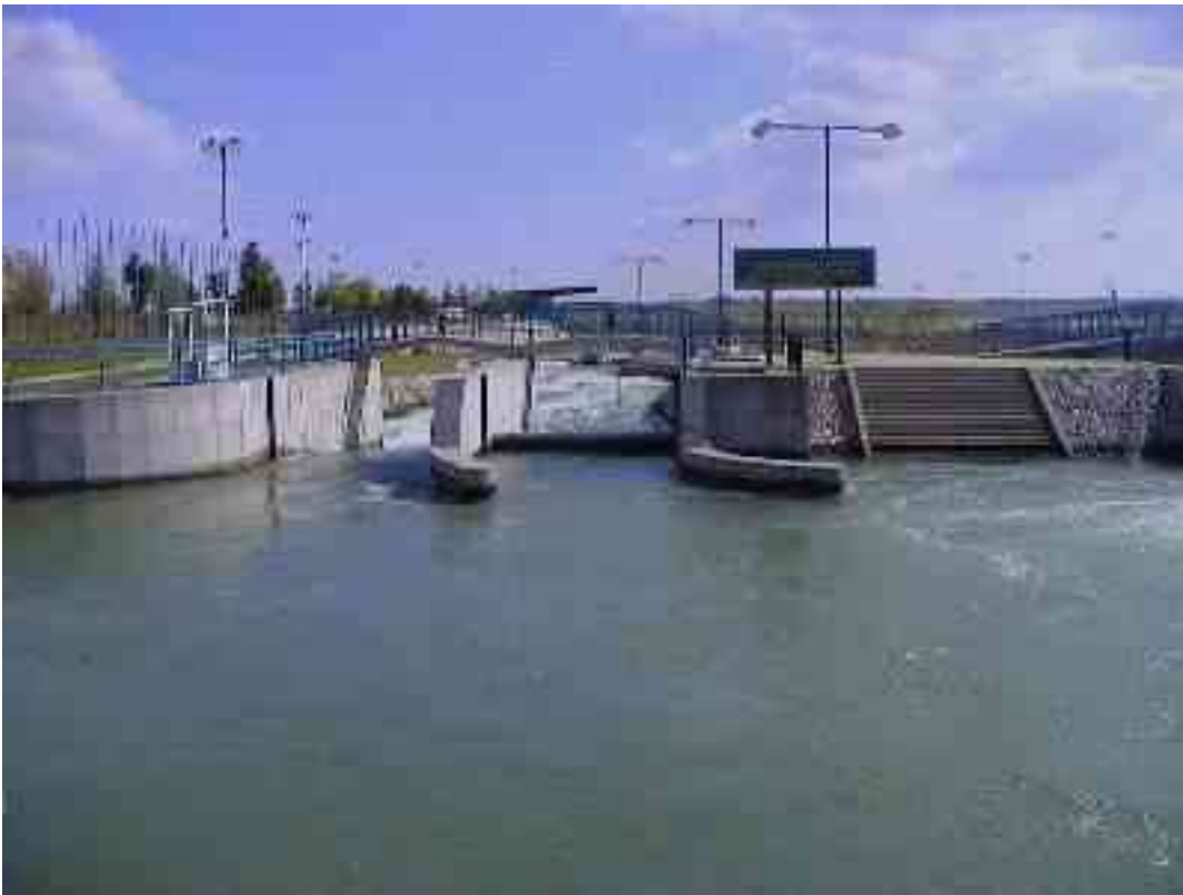
Einfahrt linker Kanal
